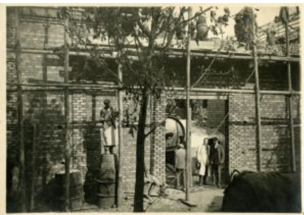
Bâtiment, probablement de la sulfuration, en construction
