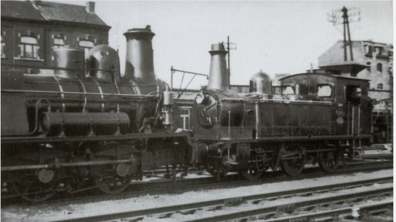
Tz 724 - Tubize type 37 - EB 415 devenue 1121 type 11 - Vue à Ans en août 1939, en compagnie d'une type 25. Elle avait été dotée d'une chaudière du 3e modèle (à cheminée tronconique) et d'une trémie. Un coffre à outil a été ajouté à l'avant et les butoirs primitifs à tige et ressort étaient remplacés par des tampons à bagues du système Ringfeder. (H.G. Hesselink). Tiré de P. DAMBLY, Vapeur en Belgique, p. 149.
