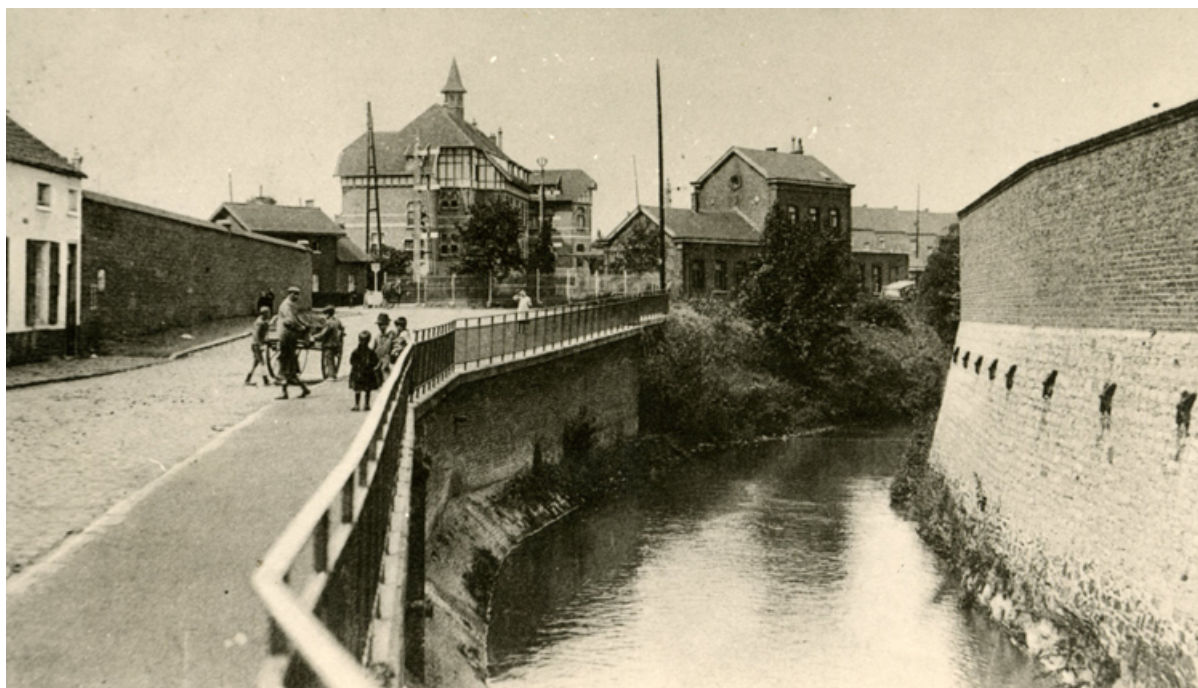
La Sennette non loin du passage à niveau et la gare de Clabecq
